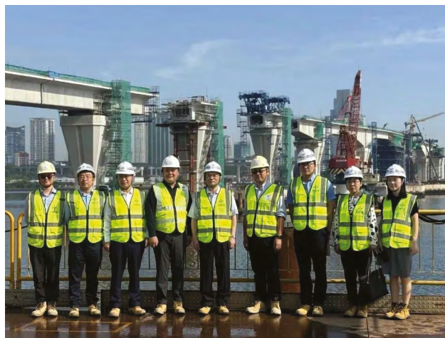
2024年6月28日，曹忠明大使安全巡视中企承建的新柔捷运T235跨海桥项目。
